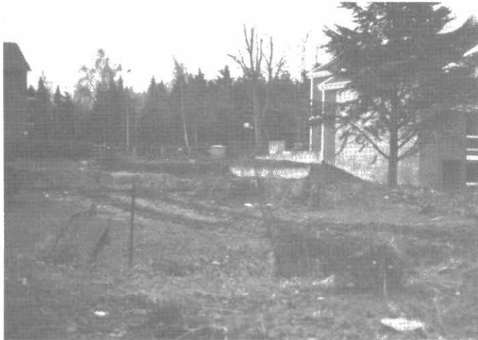
Hier wird das Bürgerhaus stehen – Ecke Kopperpahler Allee/Eichkoppelweg (rechts die Bücherei)
